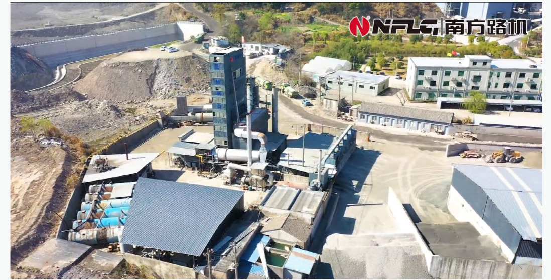
宁波长城沥青制品有限公司沥青搅拌设备
