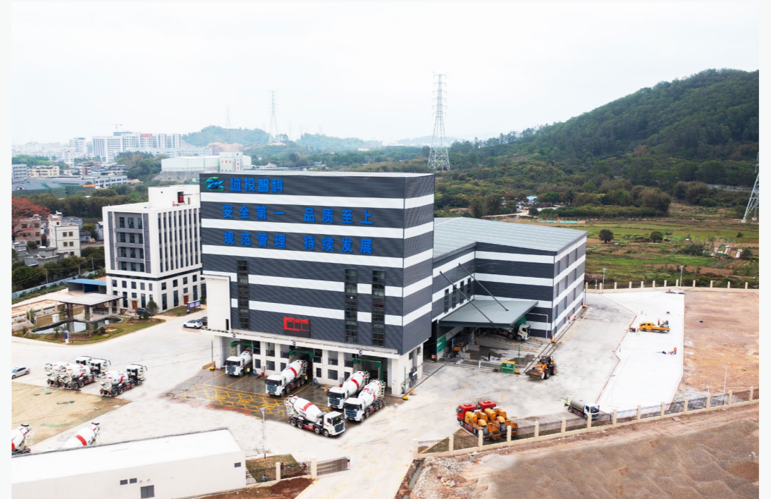
预拌混凝土搅拌站试点项目
